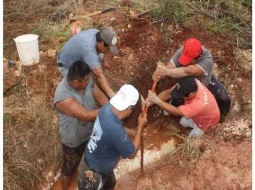
Reparación de la tubería principal de conducción, pozo número 5 de la bomba vertical 50 HP 220 Volts, kilómetro 39+300 carretera federal Campeche-Mérida lado derecho
